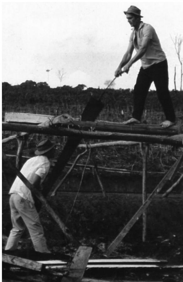
Fig. 8 - “Breat hoca”: Serra muito usada para cortar toras de madeira, para obtenção de tábuas. Mata Fria 1967. Foto gentileza do Museu Pomerano de Lagoa/ES.
